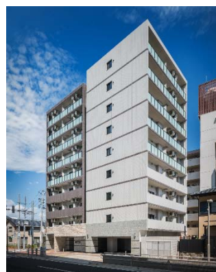
サムティ熱田RESIDENCE (名古屋)
