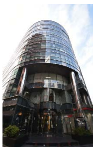
初台センタービル (東京都渋谷区)
