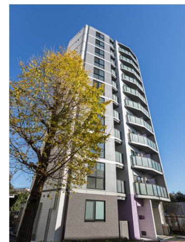
S-RESIDENCE池袋Norte
