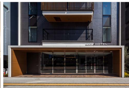
ネストホテル広島八丁堀 (外観)
