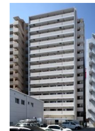
S-RESIDENCE江坂 (大阪府吹田市) マンション/138戸
