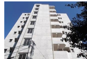
プラウランド守山 (名古屋市守山区) マンション/54戸
