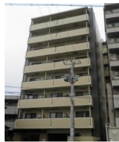
サムティ塚口レジデンス (兵庫県尼崎市) マンション/49戸
