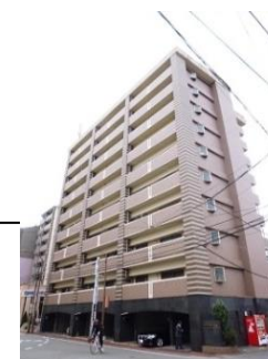
サムティ熊本呉服町 (熊本市中央区) マンション/54戸
