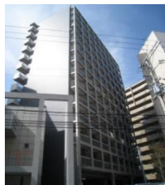
サムティ神戸浜崎通 (神戸市兵庫区) マンション/51戸
