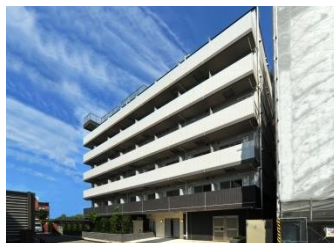
ブルーロードウーク川口並木 (埼玉県川崎市) マンション/70戸
