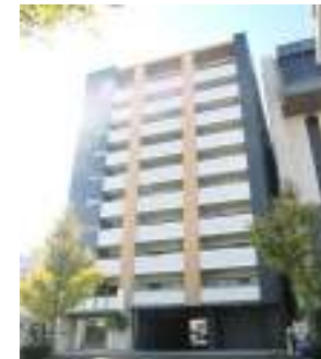
REGALO筑紫通 (福岡市博多区) マンション/90戸
