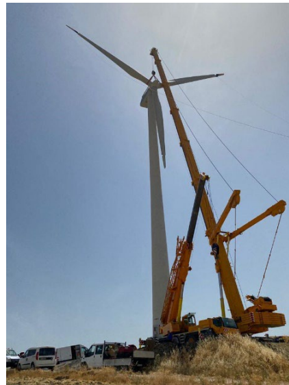
建設中のタワー
